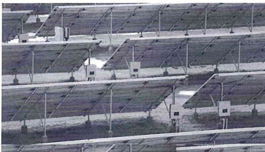
Fig.2.5 Montajul invertoarelor pe sol
